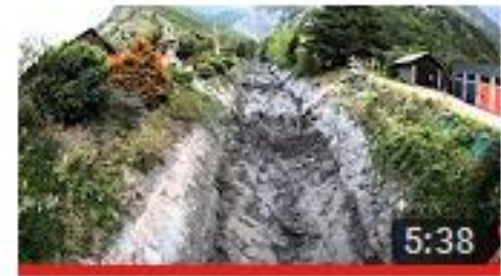
debris flow - 22 août 2011 - Crue torrentielle à Saint Julien
